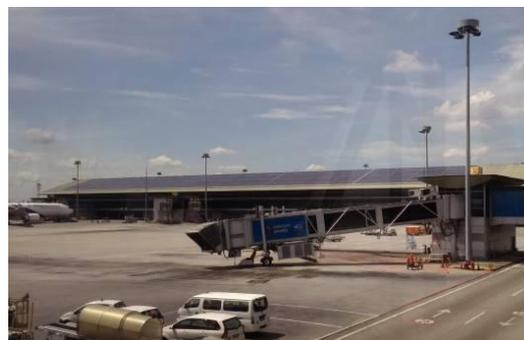
圖 30 機場屋頂設置光電板
