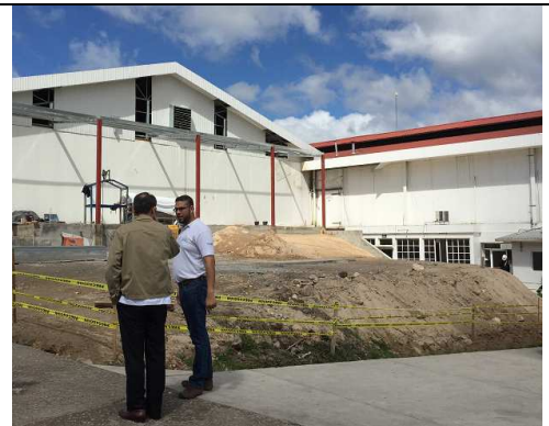
白色建築物為加工區，進行之擴建工程
