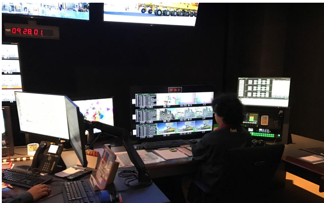
圖 18 4K 播放控制室
