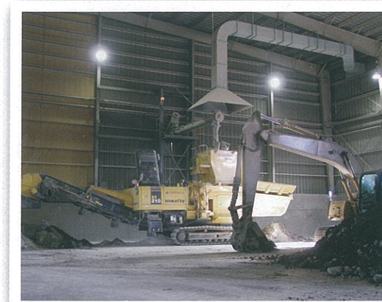
建設現場などから発生する汚れた土砂は改質材で性状を改善し、天然粘土の代替として年間6~10万トンを資源化しています。
