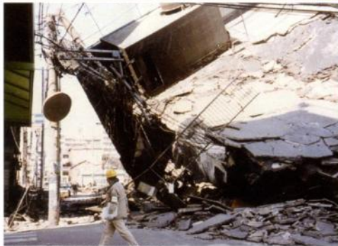
写真提供 財団法人消防科学総合センター
