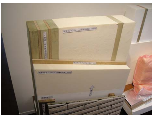
圖 10 「i-smart」住宅之外牆組成
