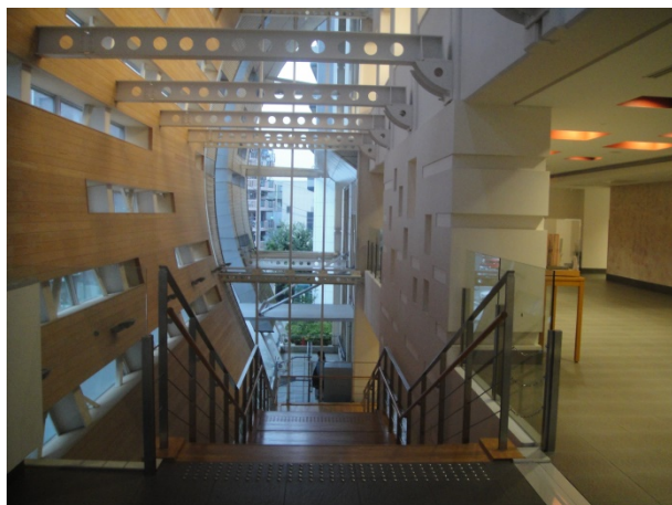
圖 17 利用增建的內部空間，新設樓梯
