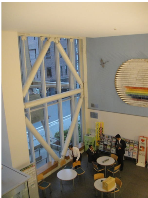
圖 21 以 V 型斜撐作為耐震補強
