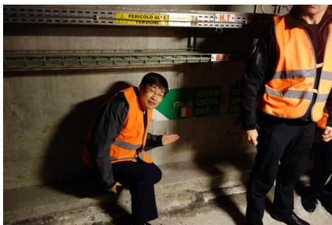
圖・白朗峰隧道下方通風管道法國與義大利交界處留影（2016/9/28）
