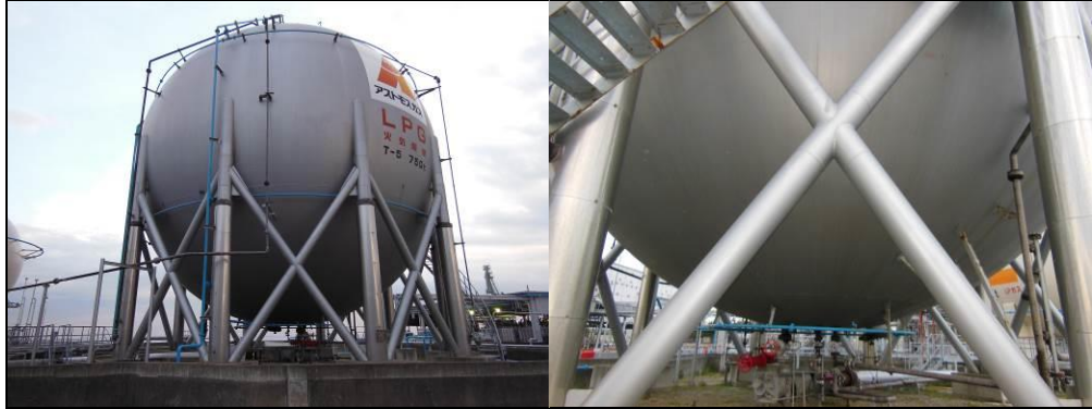
圖二十一，於高壓球槽加強支撐及基座穩固
