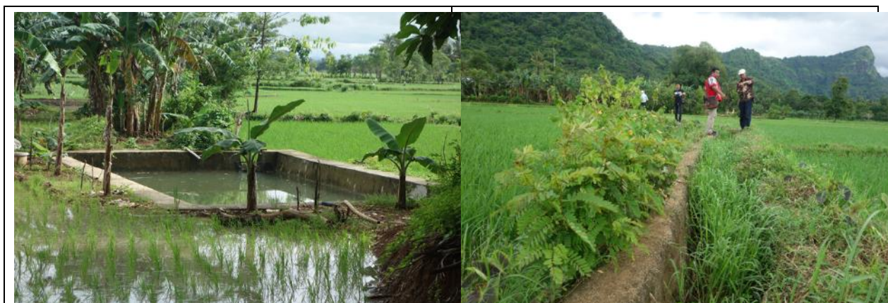
圖32. 小型蓄水設施及既有老舊漏水而荒廢無法使用之渠道
