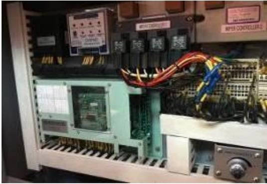
操作台後方(一般配電板 2)，各種斷路器模組、保險絲、時間延遲模組以及速度紀錄儀
