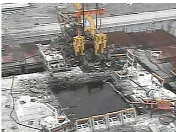
圖 15 3 號機組反應器建築物上蓋移除
