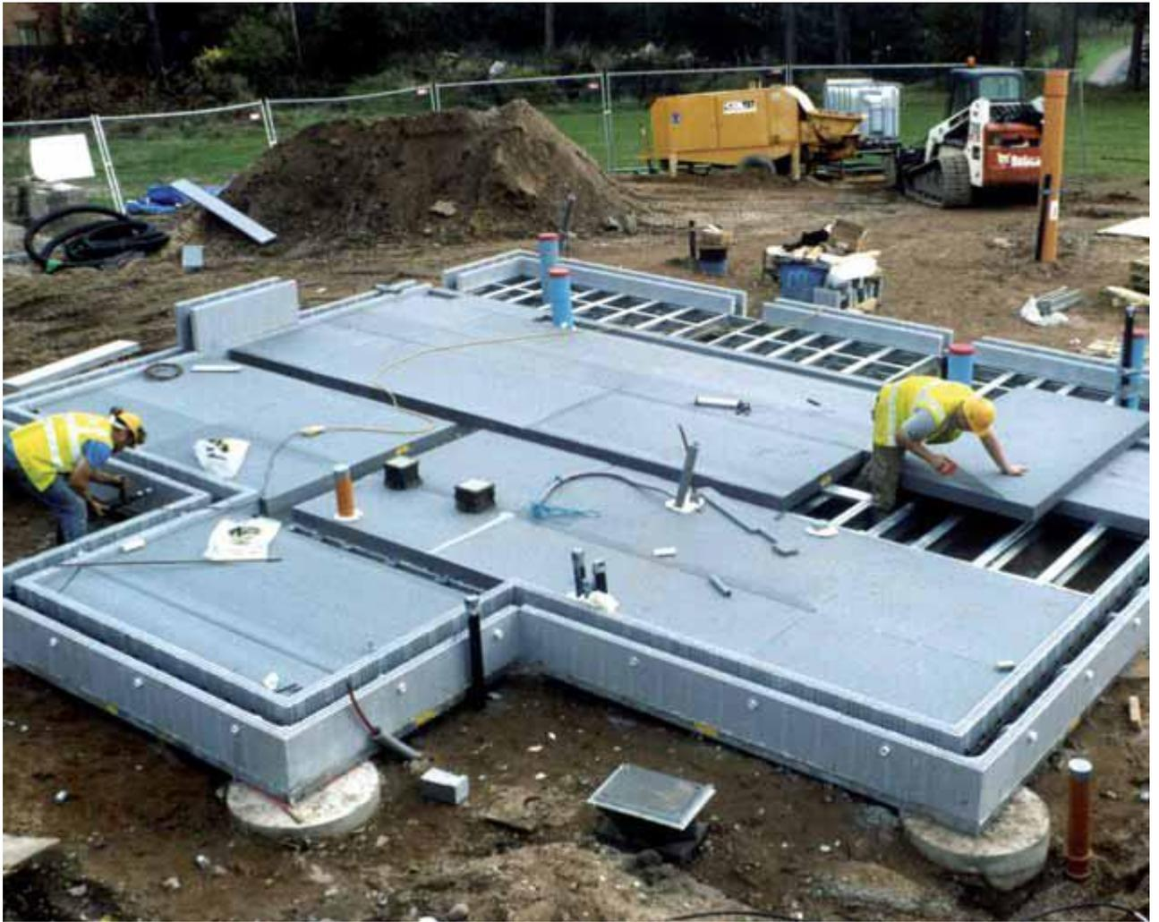
圖十二、BASF HOUSE 建造之初，打入地面的地樁，鋪設於上的地板及牆面工程[2]
