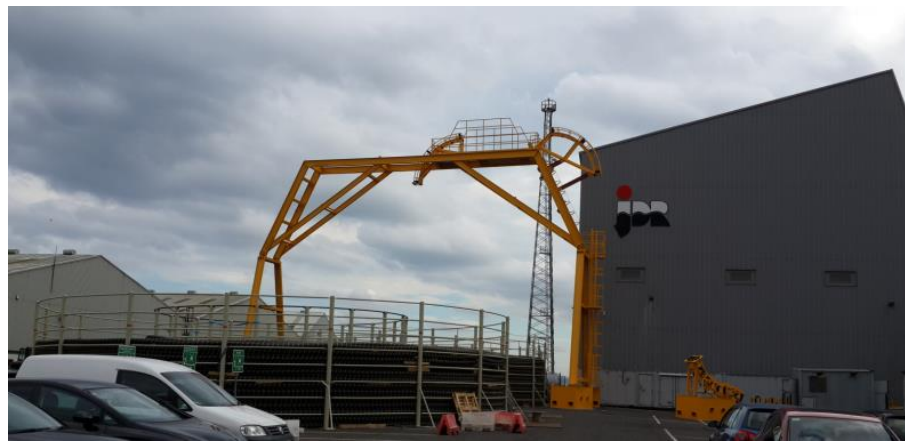
圖 63 JDR Hartlepool 海纜工廠-Cable Carousel
