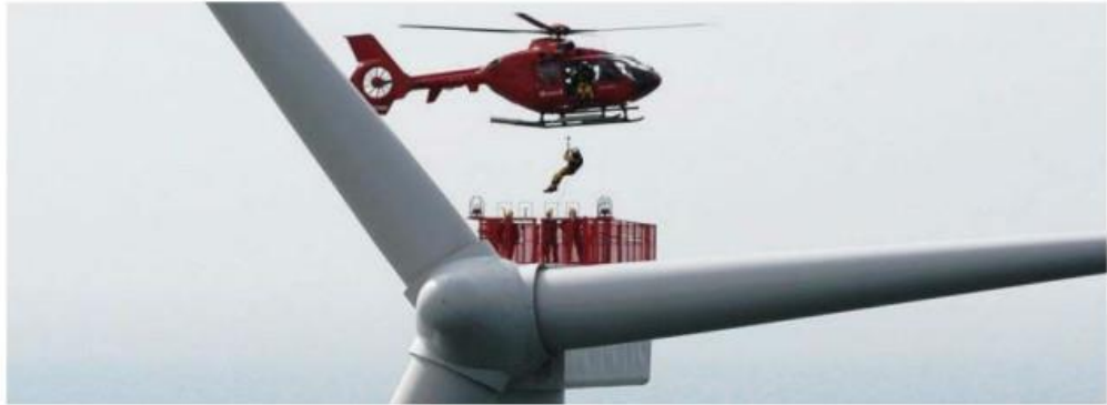
圖 32 利用直昇機進行海上吊掛作業情形
