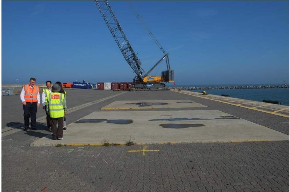
圖 27 Great Yarmouth 風電碼頭吊車重件區
