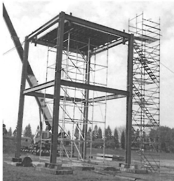
圖6 盤扣式鷹架組搭完成後之現場配置情形
