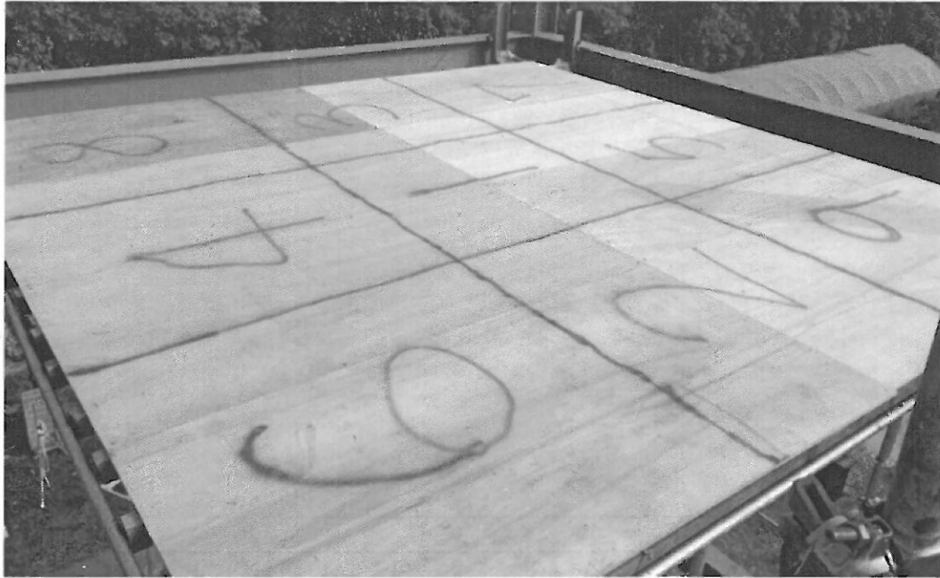
圖7 盤扣式鷹架之頂部模板承載平台配置情形
