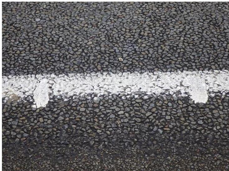
圖 2.14-1 震動標線(Vibraline)
