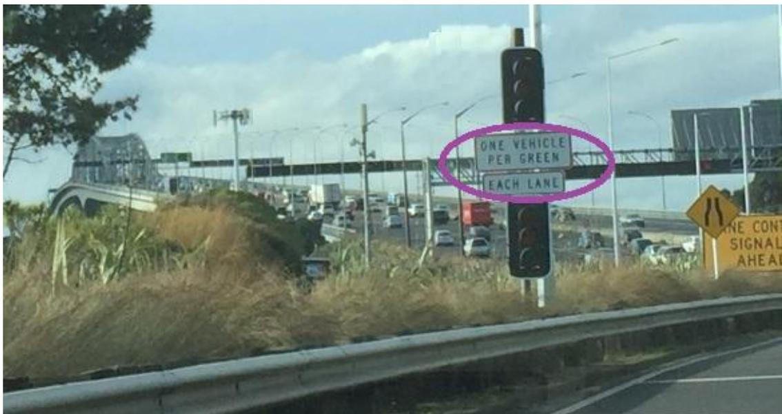
圖 2.14-4 高速道路匝道儀控(拍照時為假日，號誌未啟動)
