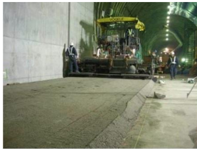
1. 鋪設底層膨潤土
