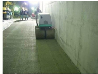
2. 夯實底層膨潤土
