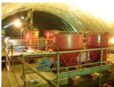
5. 自窖頂澆置混凝土進行固化
