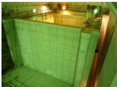
3. 建置混凝土窖體
