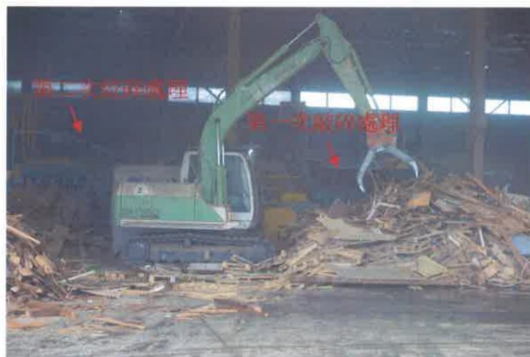
圖 4-6 廢棄建築物敲碎處理
