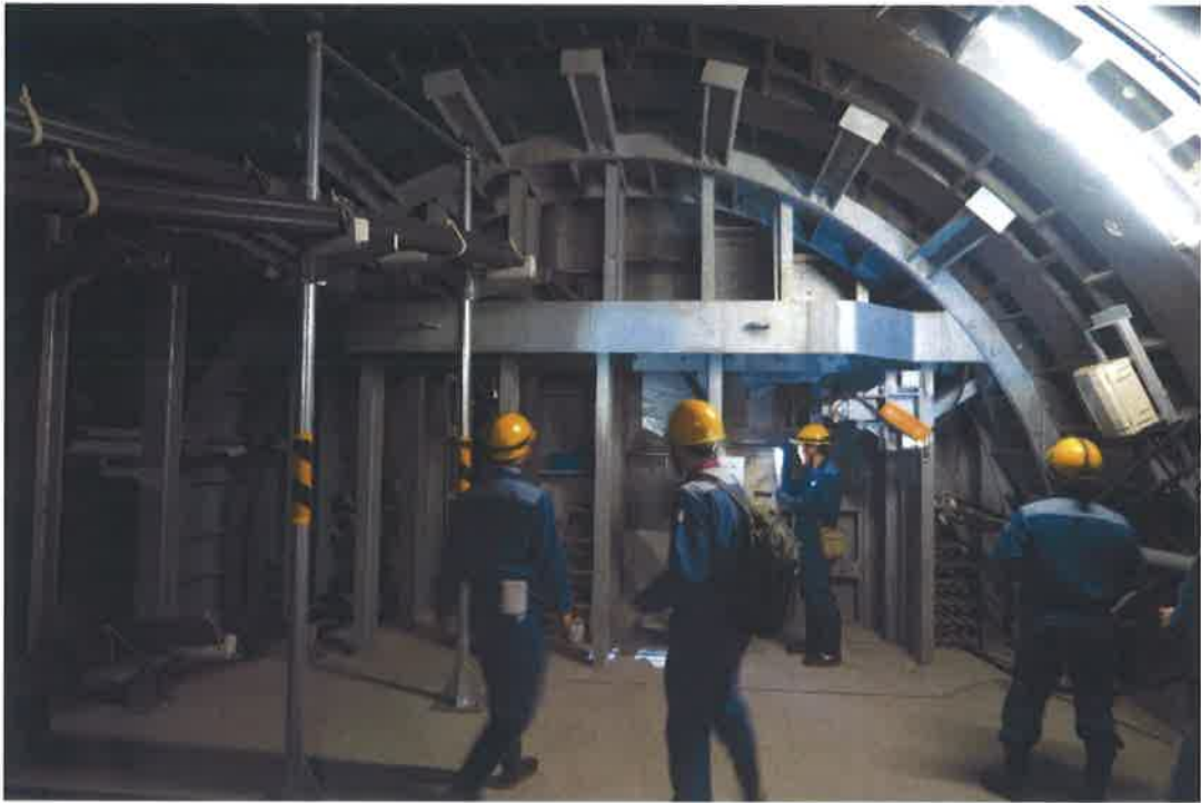
圖 3-15 電磁閥式防水門
