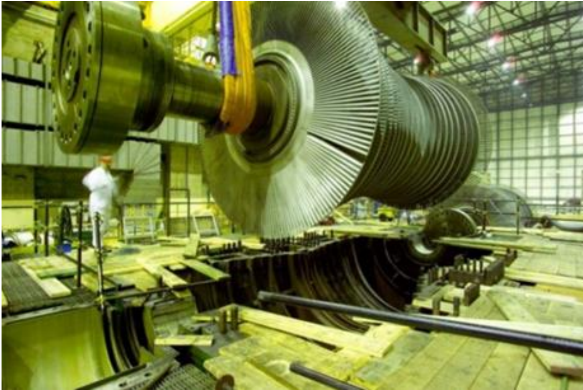
圖19、 汽機轉子移除過程
