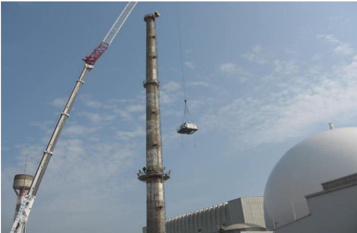
圖12、 Garigliano NPP 污染煙囪拆除作業
