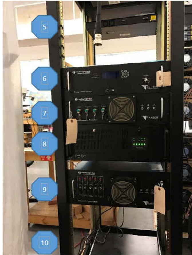
附圖 9 東沙島電子設備機櫃，自上而下為網路設備、剖風儀狀態監測電腦、射頻傳輸器、剖風儀電腦、天線電源供應器、3KVA 不斷電系統
