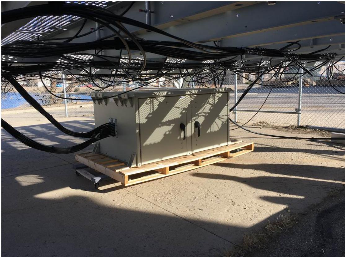
附圖 4 天線基座下方保護相移器及第 2 級功率分配器之防鏽蝕外殼
