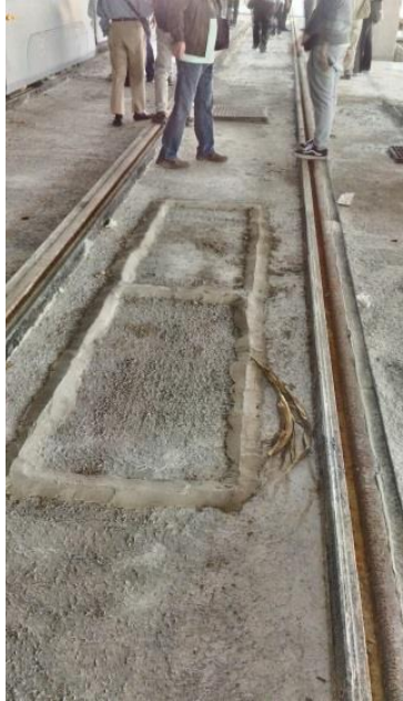
駐車區二期工程(鋪面仍待完成)
