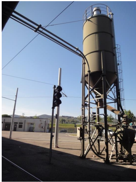
加砂工廠(外部設備)
