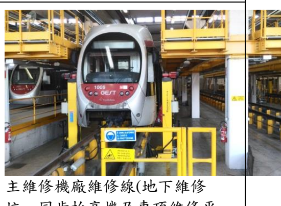
主維修機廠維修線(地下維修 坑、同步抬高機及車頂維修平 台)
