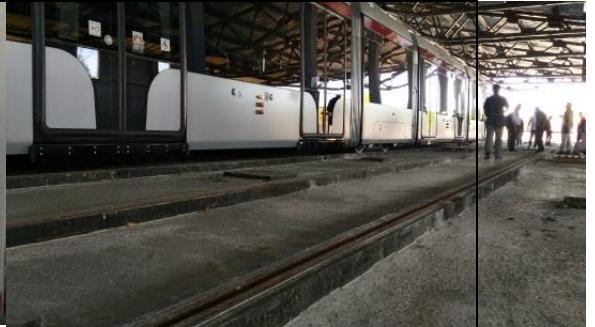
駐車區二期工程(鋪面仍待完成)
