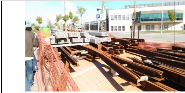
機廠戶外軌道維修區
