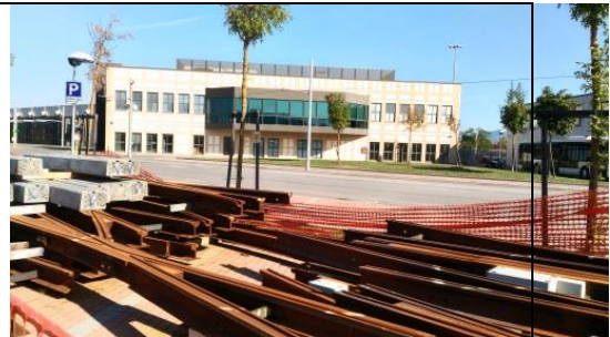
機廠戶外軌道維修區
