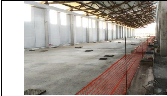
駐車區二期工程(鋪面仍待完成)
