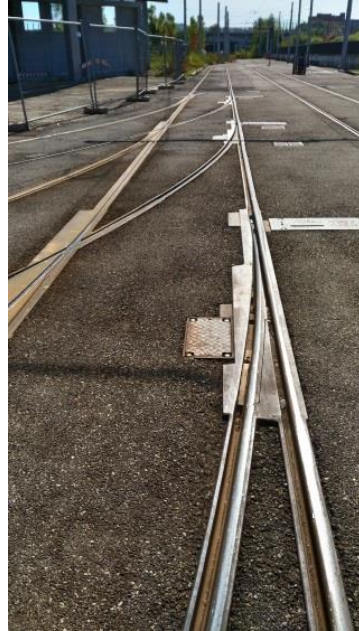
出駐車區(轉轍區設施)
