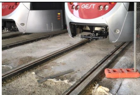
駐車區二期工程(鋪面仍待完成)
