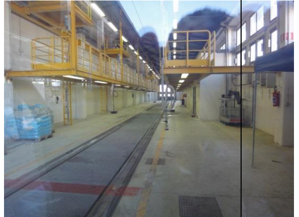
加砂工廠(內部視景)
