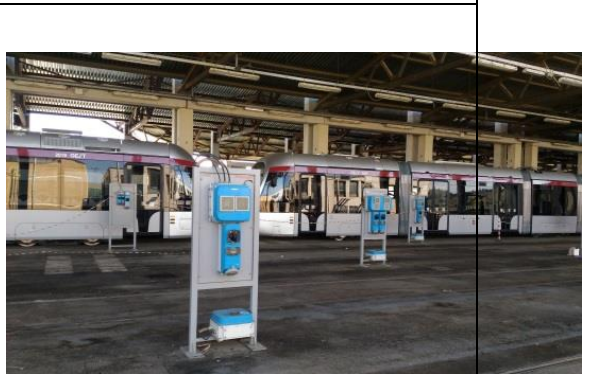
駐車區(軌旁設施)
