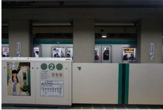
圖 4-19 京都地鐵烏丸線烏丸御池站半高式月台門
