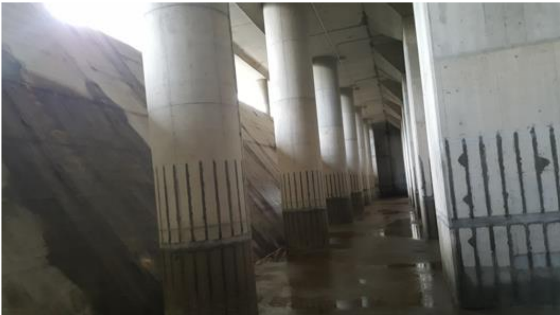
圖 25：荇原調節池地下貯水池與進水口照片
