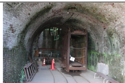
萬田坑礦坑內部。
