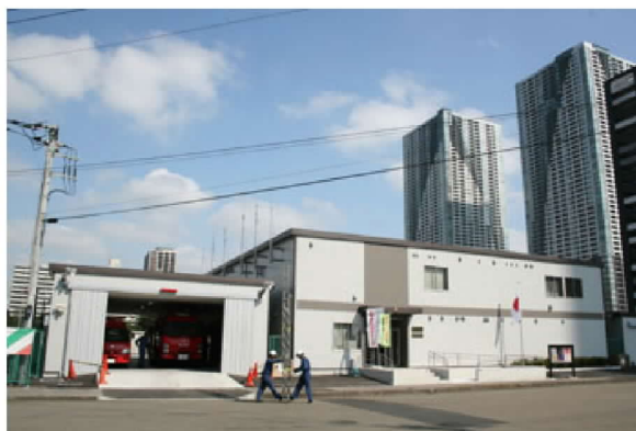
圖14 臨港消防署辦公處所
