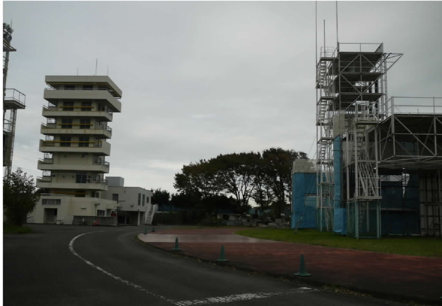
圖 48 救助訓練塔，為訓練高層建築物災害搶救及救助橫渡架設、上登下降等訓練課程活用。
