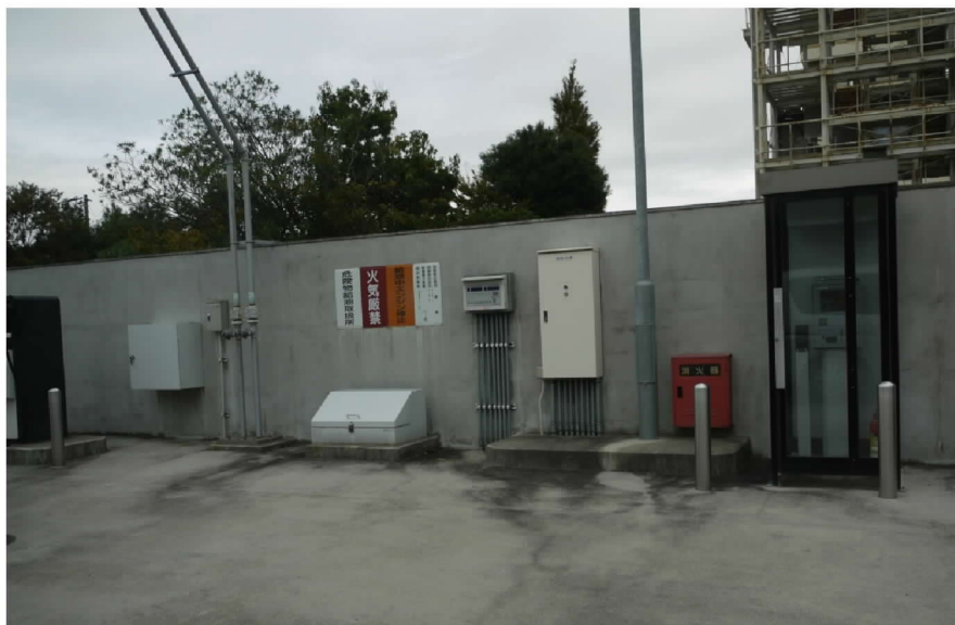
圖 47 加油站訓練場，可供加油站災害情境模擬，同時亦為中心內燃油儲油加油區（如消防車輛、大型機具）。
