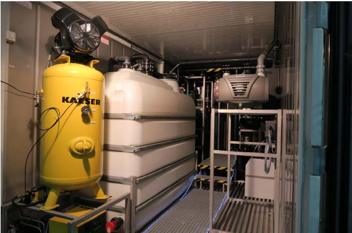
圖 3-18 PALL 公司移動型水處理系統內部構造
