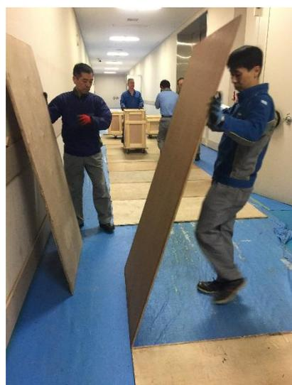
圖 15、日通人員在東博出庫房的走道上鋪設木板，以在運送木箱時保護地板。
