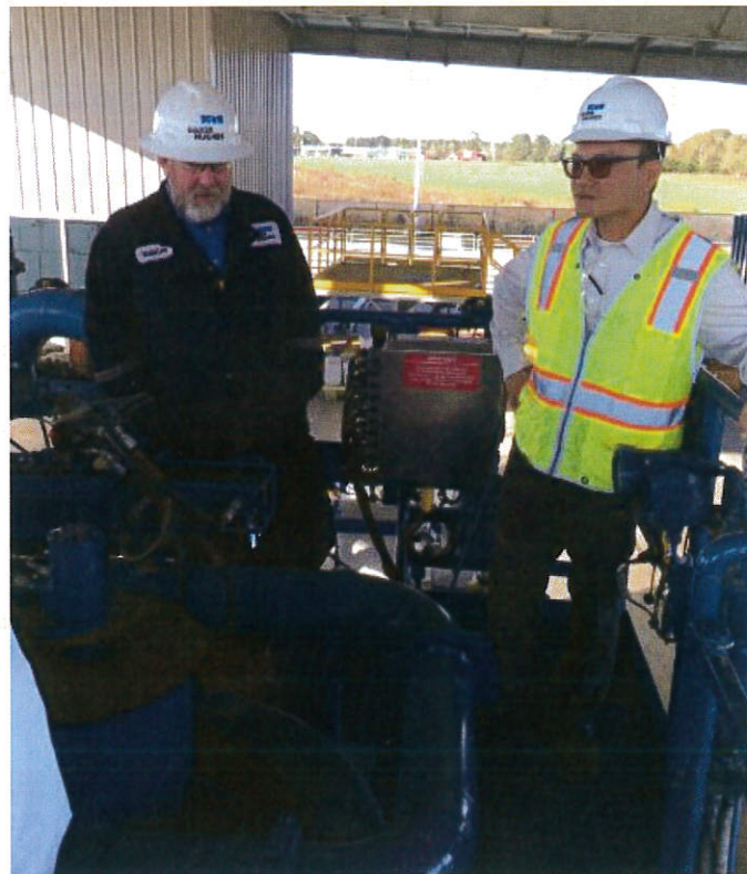
圖 21、林垠成組長與貝克休斯 Paul Unwin 討論泵浦設備情形； 左下方為放入水泥乳中藥品的入口。
