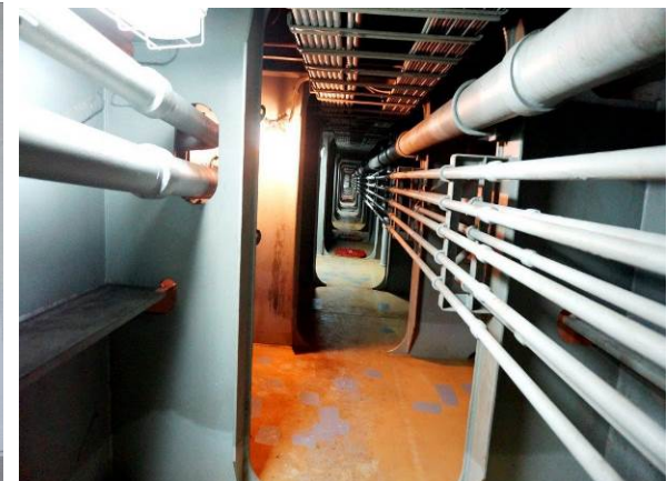
圖 17 船艙下方隧道
