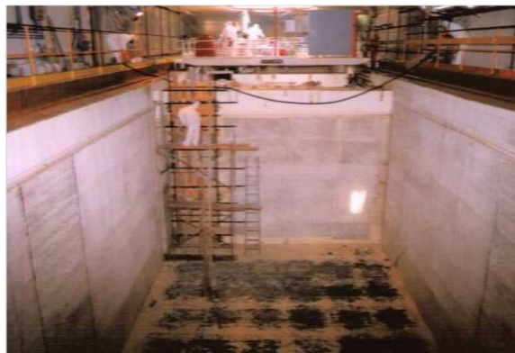
圖8 Latina核能電廠用過核子燃料池除污作業
