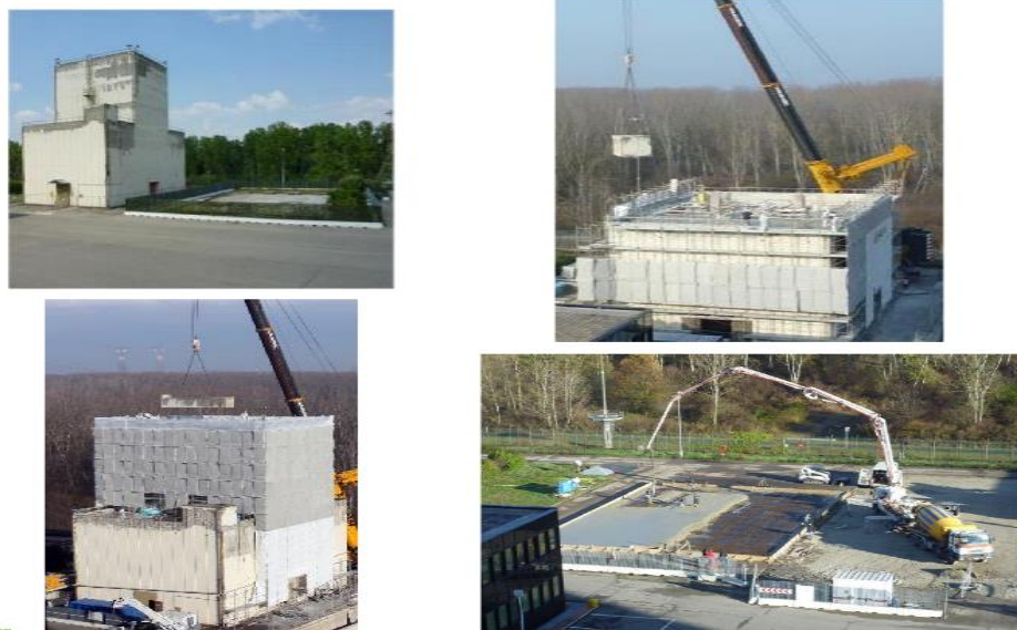
圖13 Caorso核能電廠除廢氣處理廠房拆除(2007-2010年)
