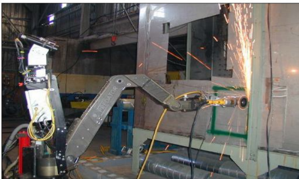
圖 13 機械手臂進行切割前的模擬試割
