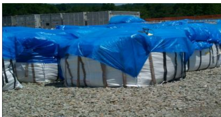
圖 18 放射性廢棄物管理貯存場之低放射性廢棄物以太空包方式貯存
