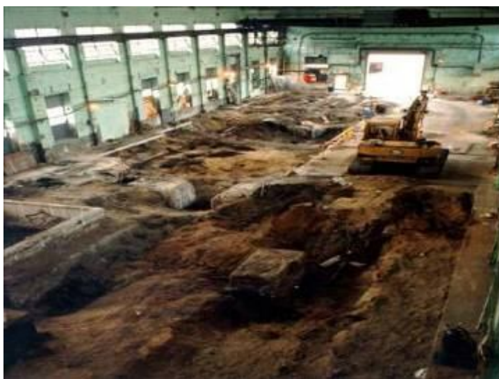
圖 8 拆除某核設施廠房，連同廠址地面下受污染土壤一併挖掘清理
