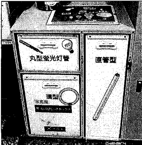
廃照明光源回収施設
