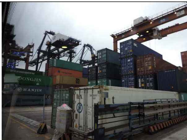
岸上的固定式龍門吊機
