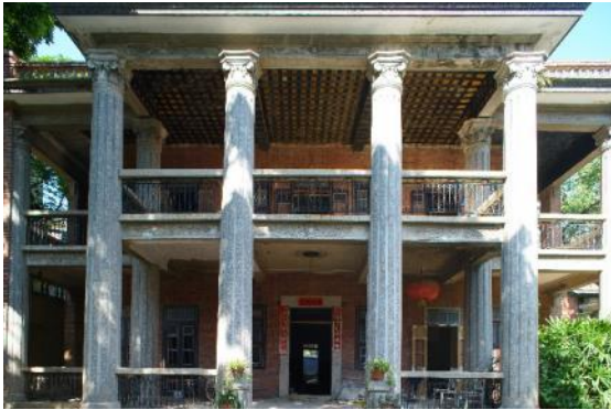
照 193 許家園（修復中，鹿礁路）
