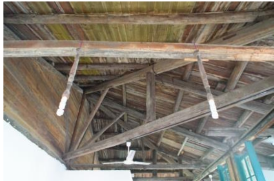
照 16 復園里一號屋架由福州杉木結構而成
