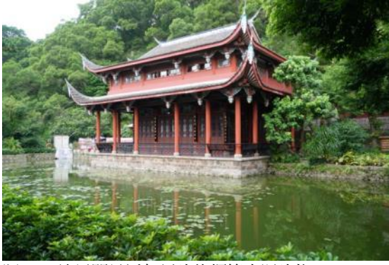
照 70 追思閣是近年新建的鋼筋水泥建物
