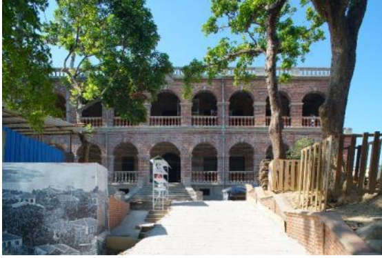
照 191 日本領事館舊址修復中（鹿礁路 24 號）
