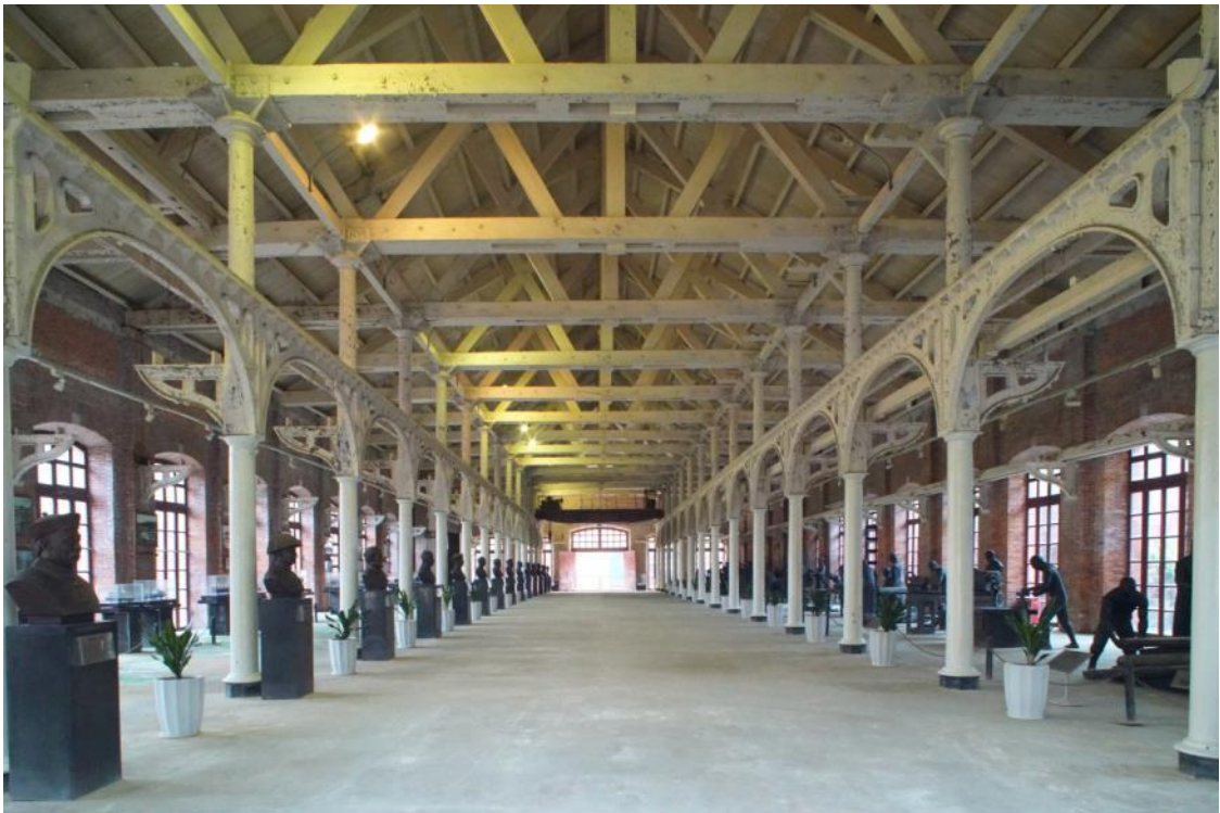
照 49 輪機廠室內的大木桁架與鑄鐵柱、天車軌道等
