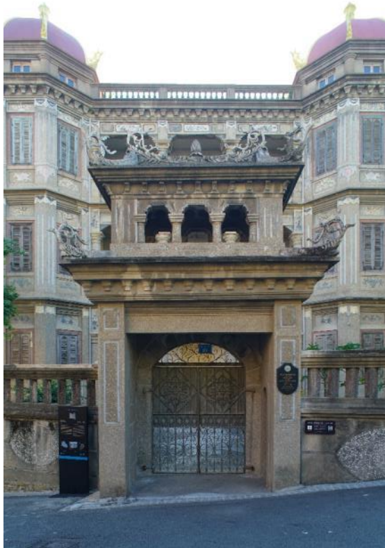
照 179 金瓜樓 (泉州路 99 號)
