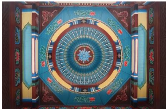
照 69 拜殿天花仰視
