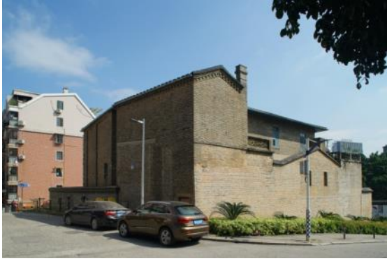
照 9 林森故居北向立面
