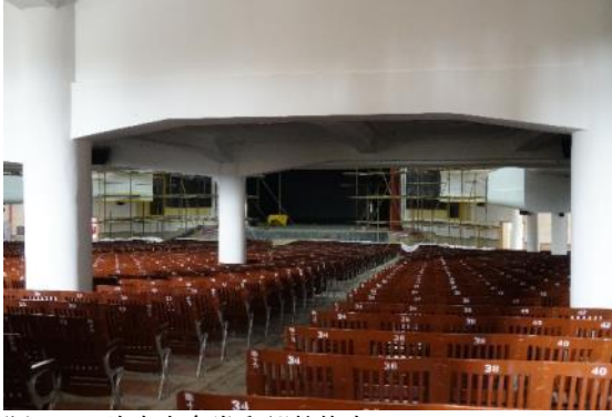
照 251 建南大會堂內部整修中
