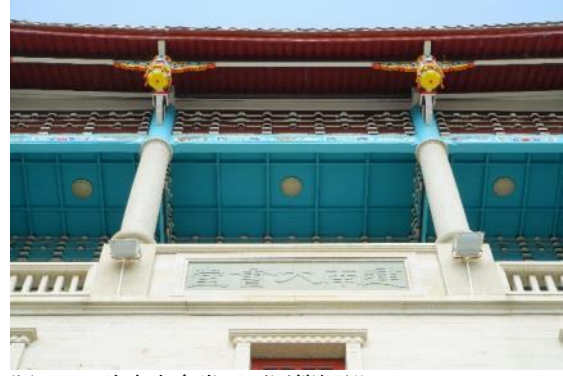
照 252 建南大會堂正面屋簷細部
