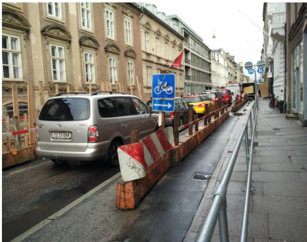
道路施工仍提供自行車專用道
