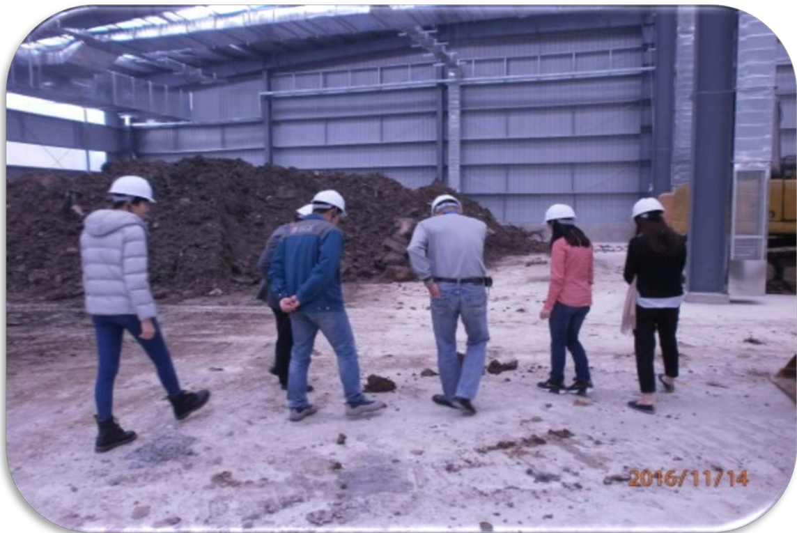
圖 4-14 參訪上海土壤污染整治場址室內處理場(1/2)
