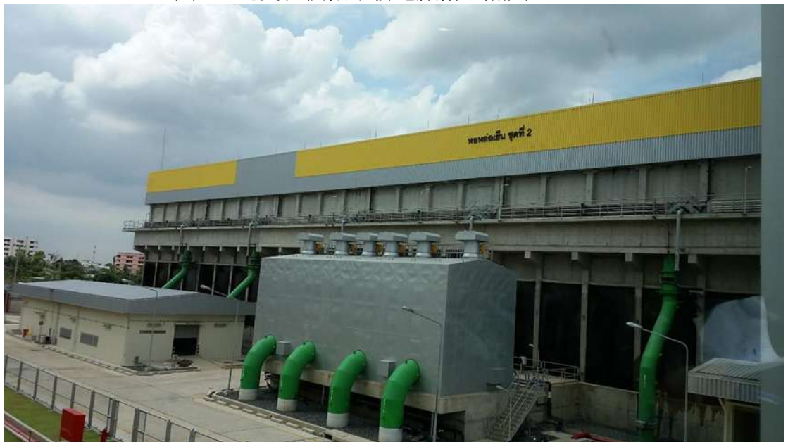
圖 46 2 號機冷卻塔近照
