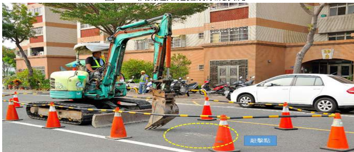
圖 30 挖土機敲擊方式
