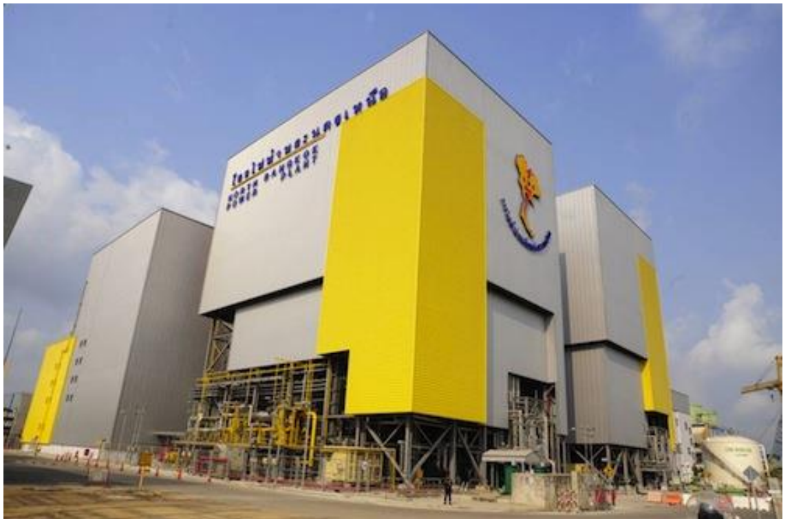
圖 44 北曼谷複循環發電廠近照
