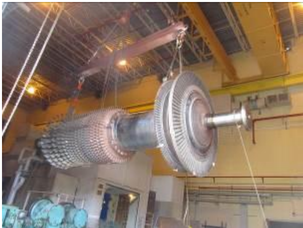
照片 1：氣機轉子吊離
