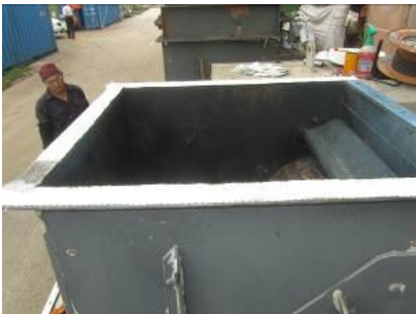
照片 29：排風扇膨脹接頭風管石綿帶更新
