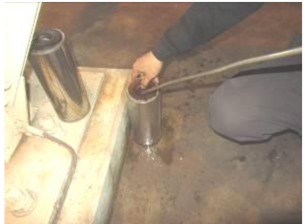
照片 28：液壓油過濾器清理
