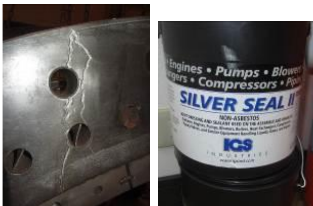
照片 5：氣機外缸刮痕塗抹 silver seal II (密封劑)
