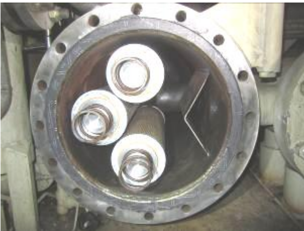
照片 23：主潤滑油過濾器濾網更新
