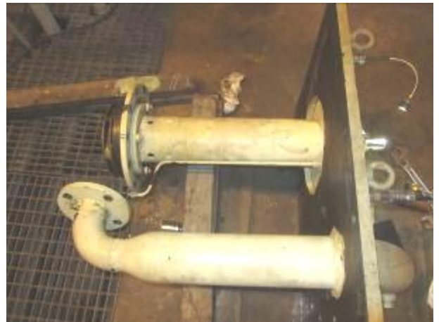
照片 24：輔助潤滑油泵拆檢
