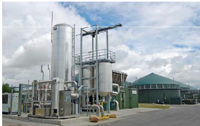
圖十二 以玉米及甜菜渣為料源之生質沼氣生產廠(Rackwitz, Germany)
