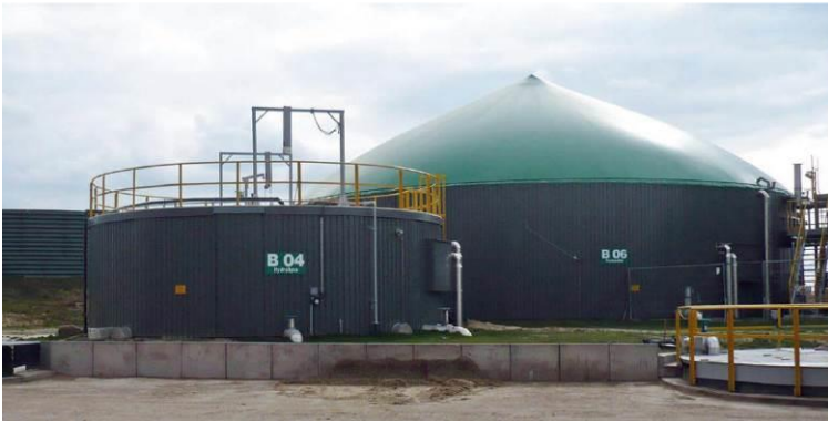
圖二十二 厭氧發酵前之半好氧水解槽(A)河北京安瑞能沼氣廠水解槽(建置中)；(B)德國 wittgendorf 沼氣廠水解槽(已運轉)
