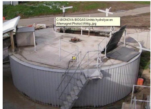
圖二十二 厭氧發酵前之半好氧水解槽(A)河北京安瑞能沼氣廠水解槽(建置中)；(B)德國 wittgendorf 沼氣廠水解槽(已運轉)
