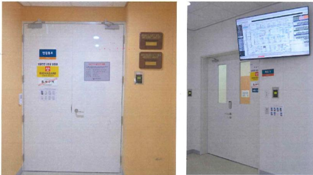
圖 4. 生物安全等級三級設備入口處具螢幕顯示三級區內各空間的溫濕度及壓差等即時訊息。
