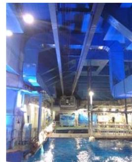
圖 8-4 鯨鯊自動運搬設施設備(玻璃纖維運搬船、高空滑軌、大型閘門)
