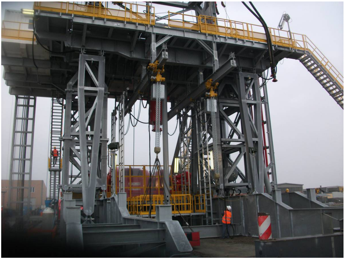
照片十三 BOP HANDLING SYSTEM 吊重測試
