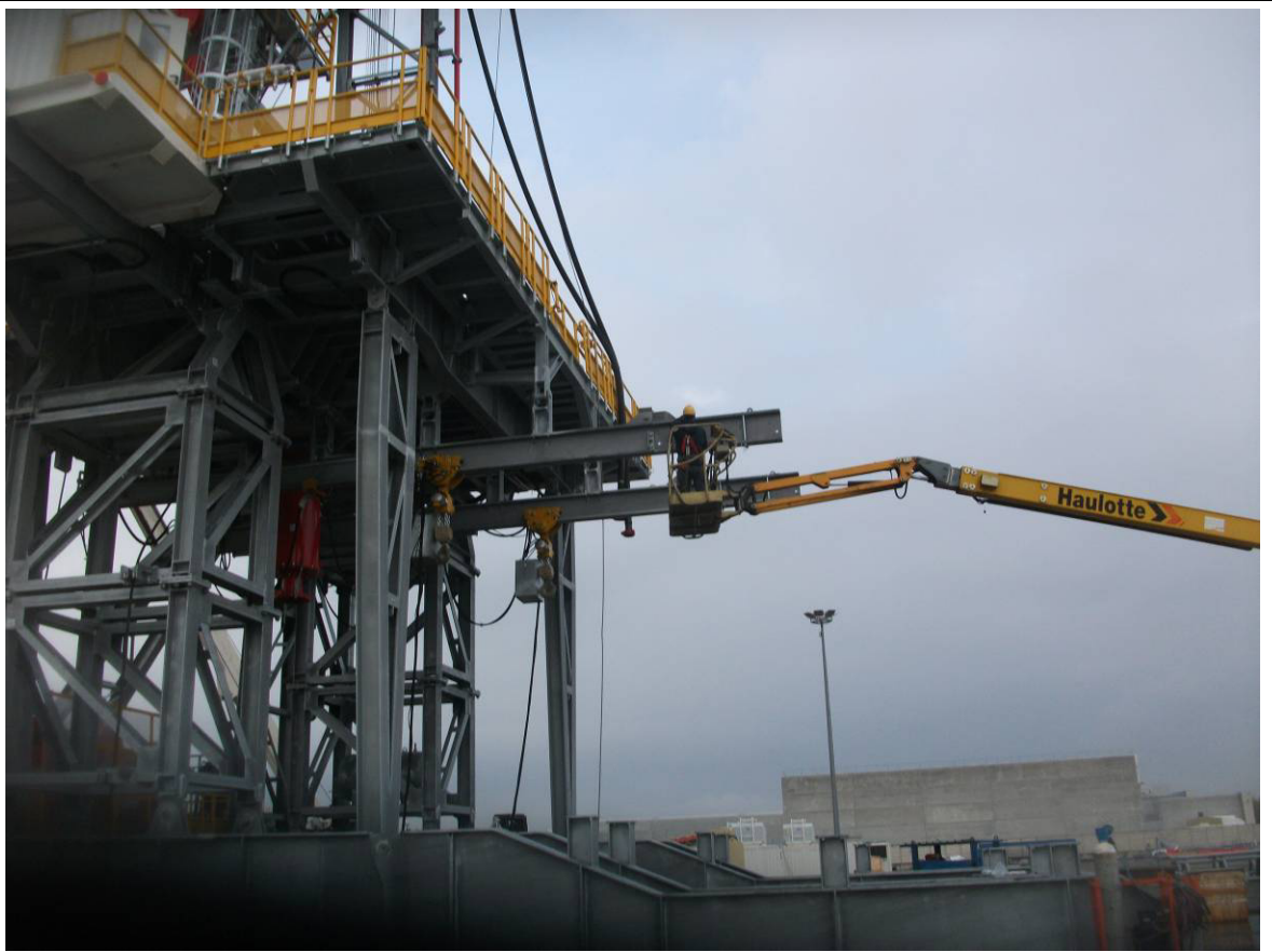
高空作業車照片(一)
