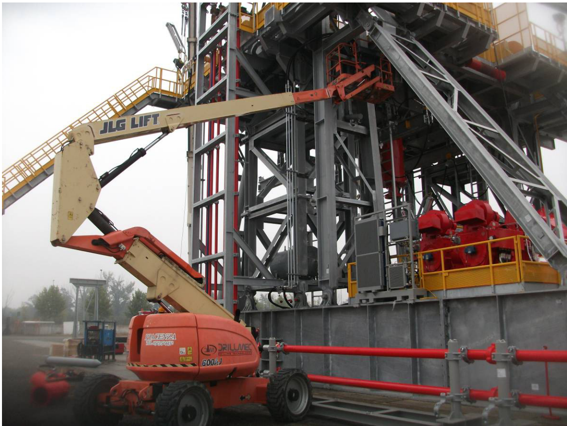
高空作業車照片(三)
