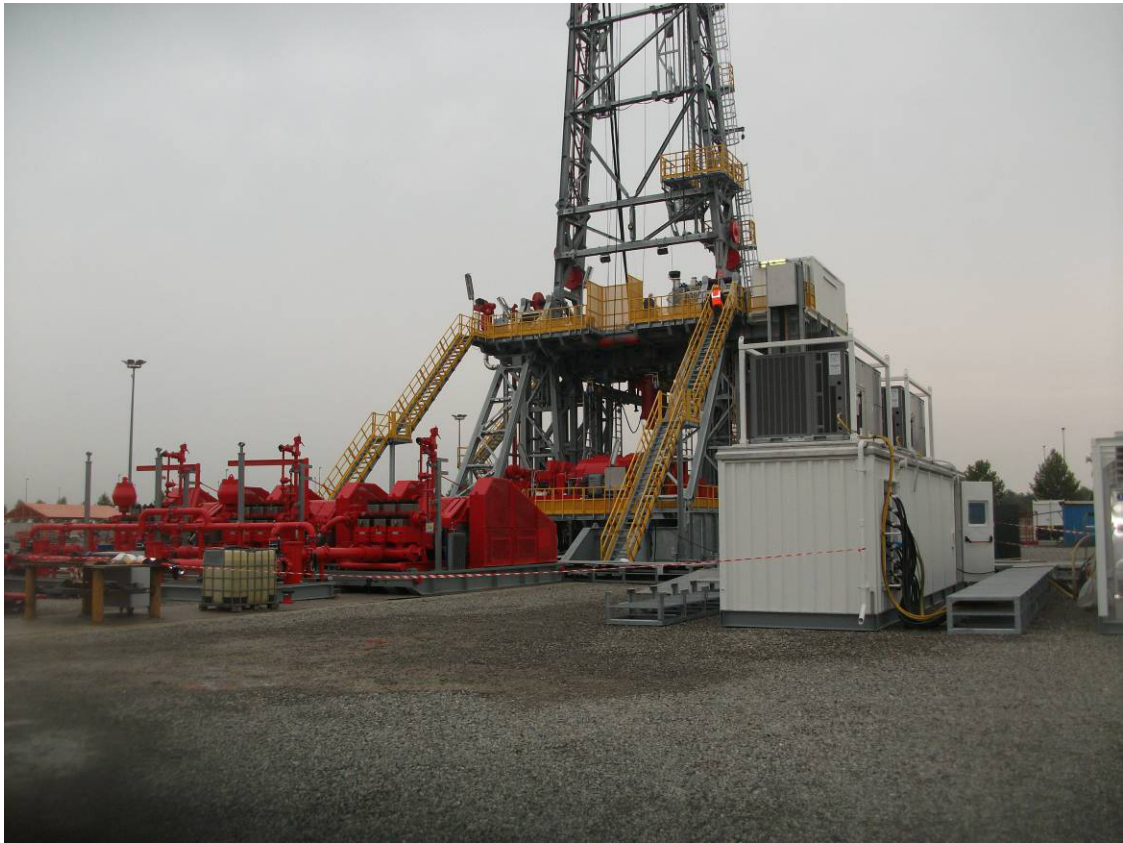
照片七 泥泵區全景
