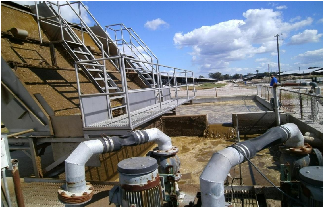
圖 43 畜牧糞尿固液分離設施
