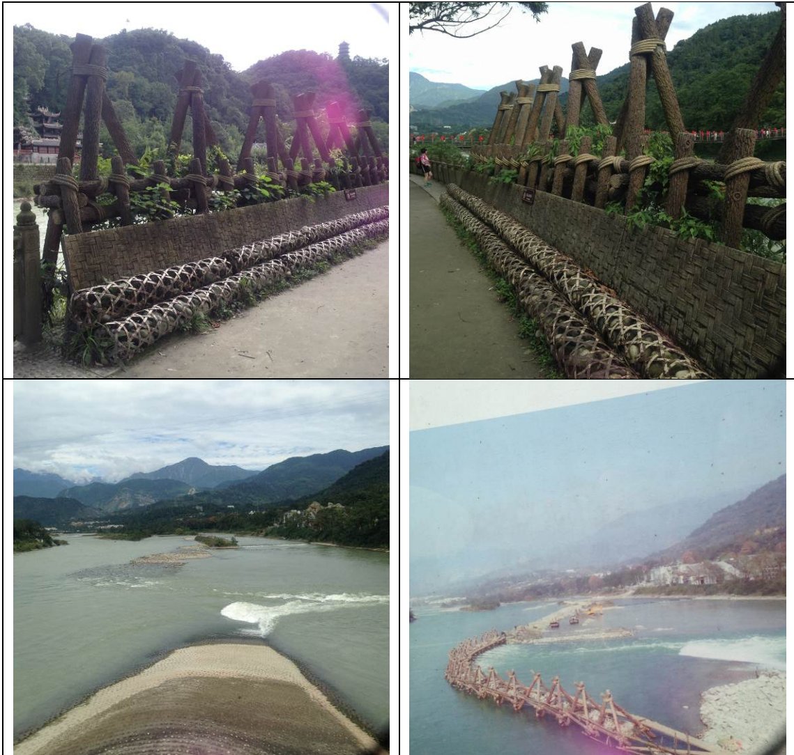
圖 11. 都江堰主體結構，乃利用傳統技術製作的竹籠和杓槎，造成凹沖凸淤束水分流效果（左上、右上）。都江堰最前端魚嘴近照(左下)、杓槎突出造成淤沙分流(右下)。
