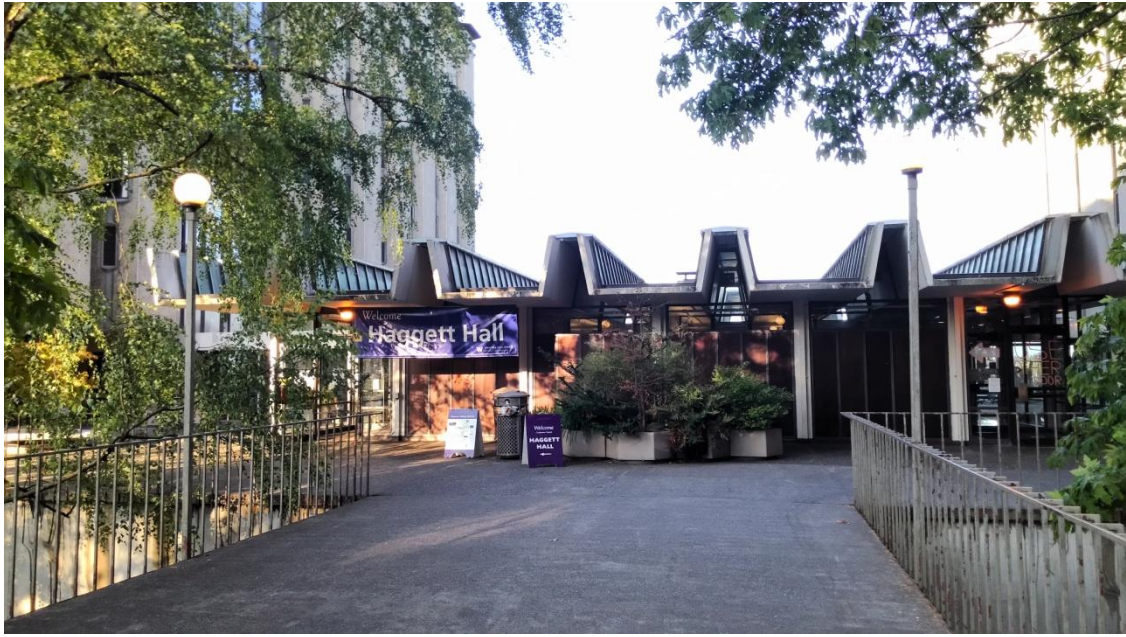
圖二、宿舍 Haggett Hall
