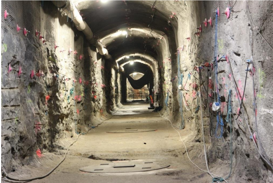
圖 11 隧道壁上之監測樁
