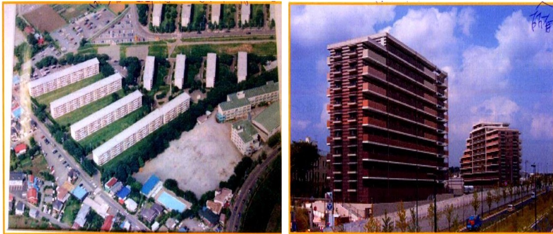
町田山崎住宅建替事業
