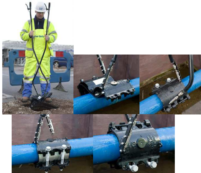
圖 49 夾具修漏方式
