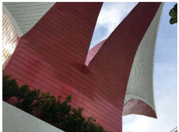
圖 61-頂樓外氣引入系統花瓣結構
