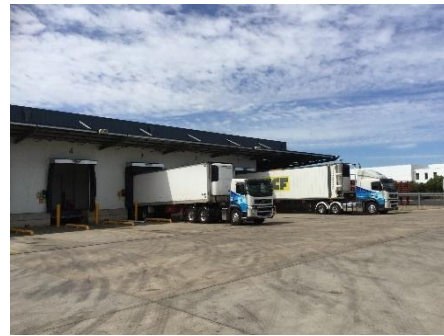
圖 62.運送貨車與冷藏倉庫連結以利貨物裝卸
