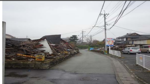
上圖：益城町社區內巷道，仍有未清理的倒塌房舍
