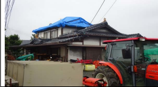
上圖：益城町社區內正在重建的房舍
