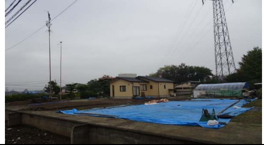
上圖：益城町社區內移為平地正興建房舍中
