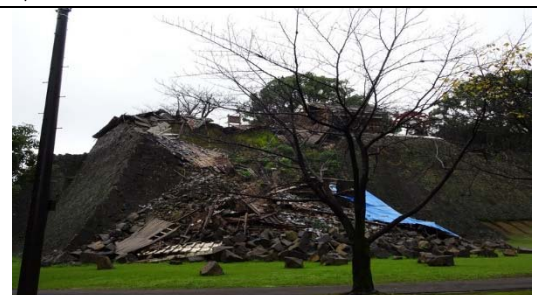
上圖：熊本城坍塌滾落的建物基座及土方
