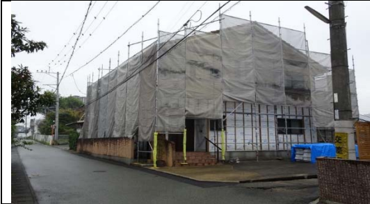
上圖：益城町社區內正在重建的房舍
