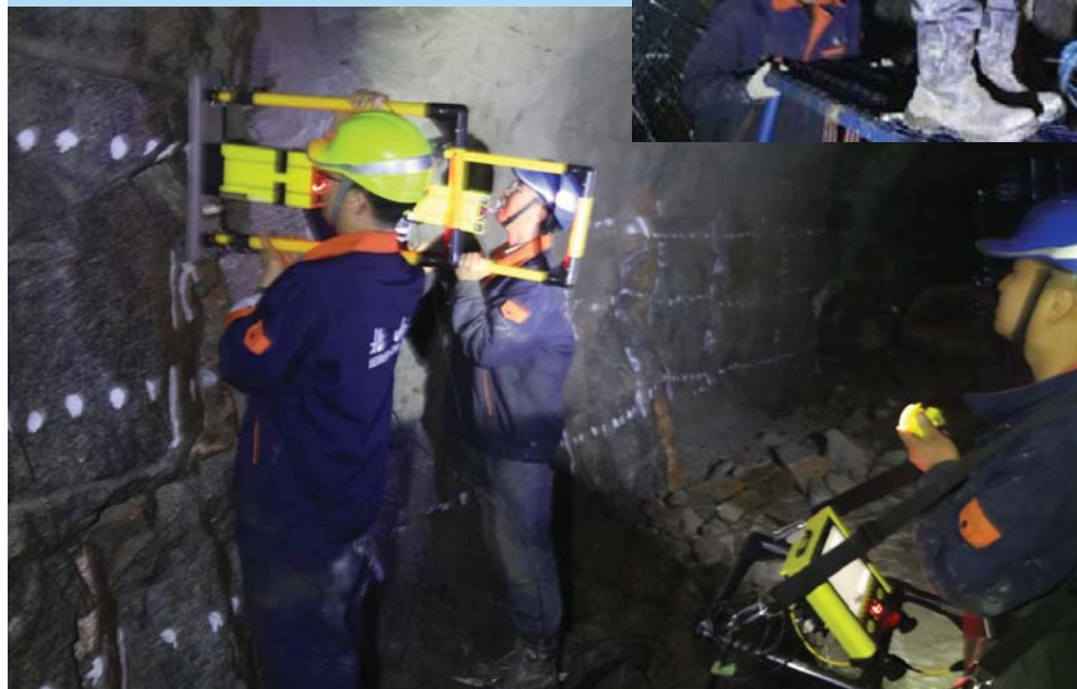
EDZ试验现场测量
