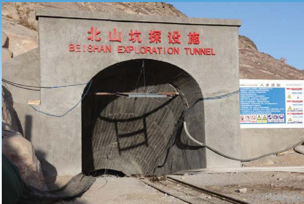
坑探设施硐口
