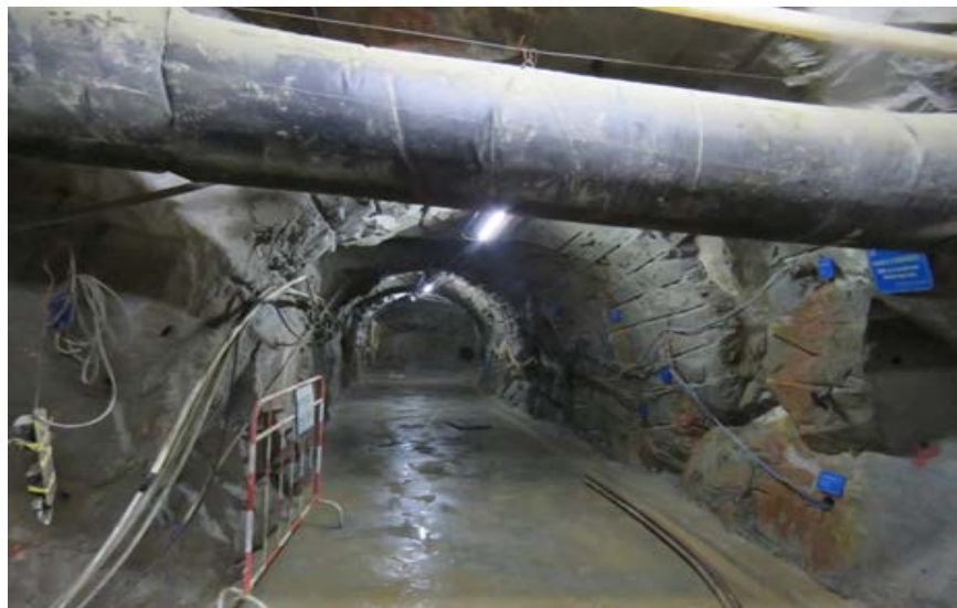
地下水監測試驗硐室
